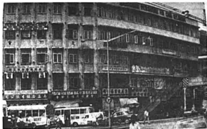
GAMBAR 5 Bangunan Foch Avenue, Kuala Lumpur yang pernah menjadi pejabat Parti Komunis Malaya
